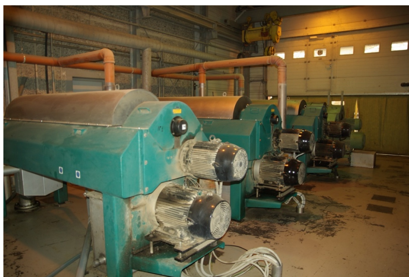
9.attēls. Lieko dūņu blīvēšanas dekantercentrifūgas.
