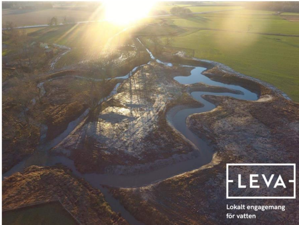
Färdigrävd våtmark hösten 2020. Foto Edlunds schakt AB
